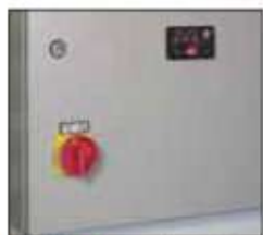
带显示单元的柜体前视图，显示易见，安装在前门面板上，保护器单元安装在柜体中。
